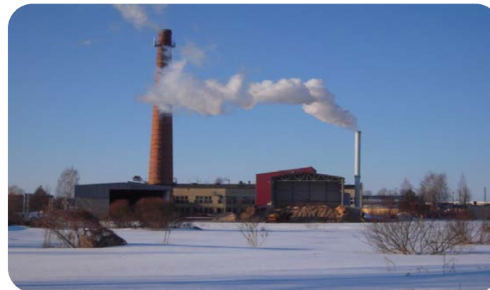
Biomass boiler house Võrusoo (27 MW)
